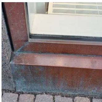
Skyltfönster och dörrar har profiler av lackerad koppar.
