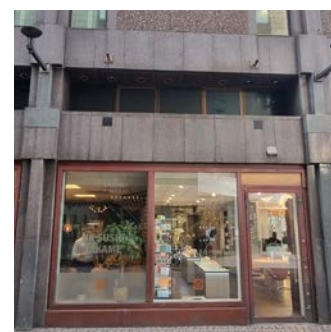
Ovan skyltfönstren finns indragna fasadpartier som ursprungligen var en del av arkadgångarna.
