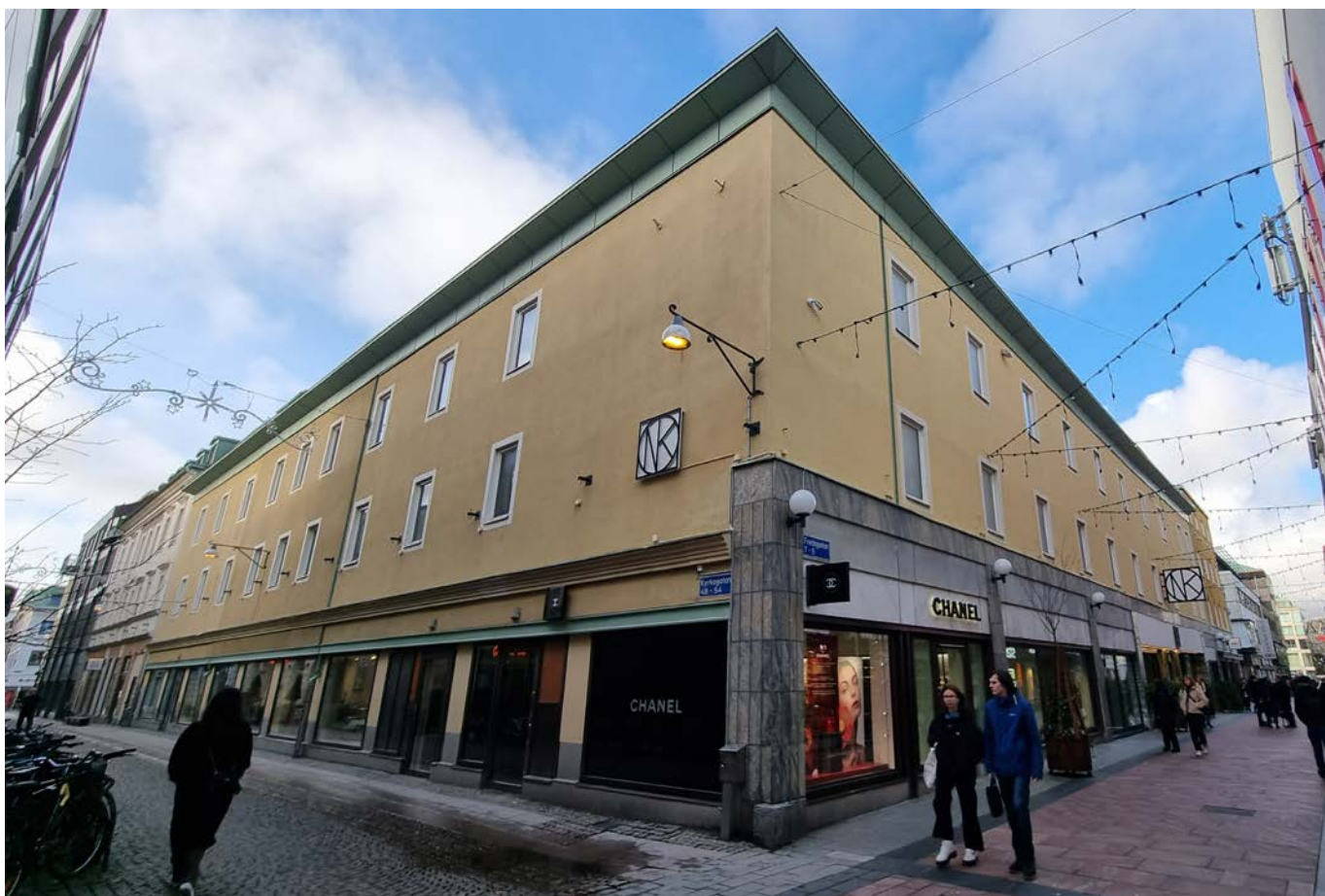
Gatufasad i hörnet Fredsgatan/Kyrkogatan. Byggnadens exteriör har genomgått stora förändringar sedan uppförandet på 1960-talet.
