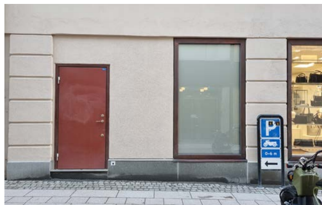
Ståldörr i ett av skyltfönsterfacken som ger fasaden ett förenklat uttryck och gatan en baksideskaraktär.
