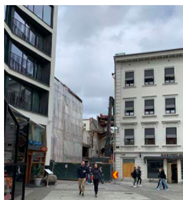
Vallgatan efter rivning av den äldre byggnaden.
