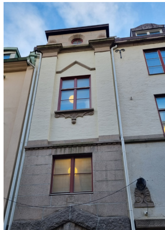
Trapphusparti med pilastrar som bryter takfoten. Notera fönstrets dekorativa understycke.
