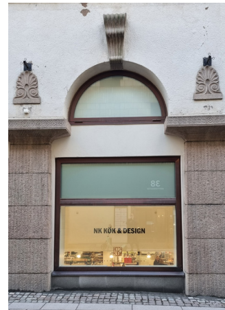
Skyltfönster med överljusfönster samt naturstensdekor i form av stenpilastrar, slutsten och acanthusblad.
