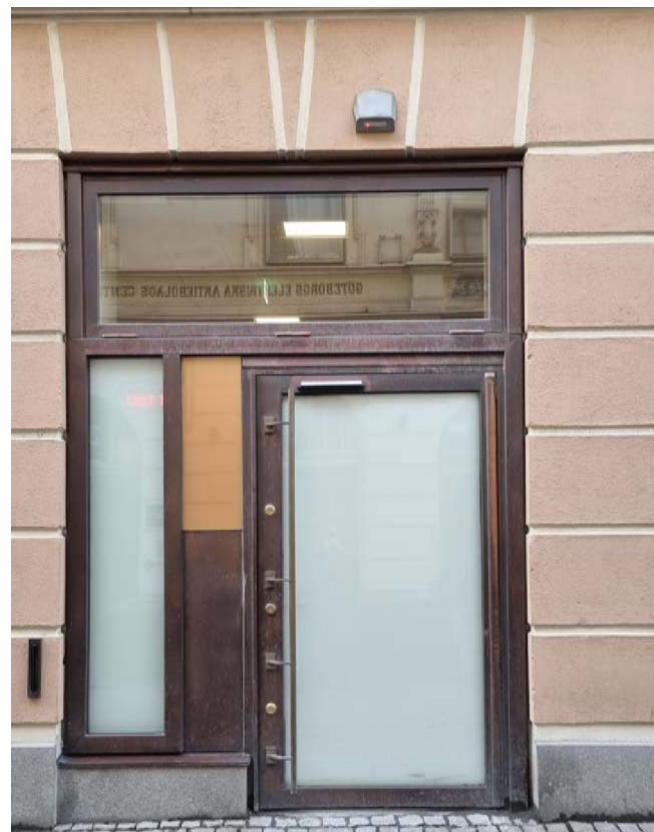
Entréparti av lackad koppar.
