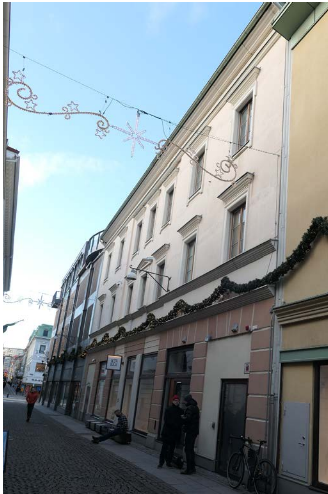
Gatufasad mot Kyrkogatan, utförd som en kuliss utan koppling till interiören.
