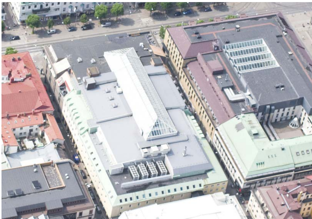
Snedbild som visar dagens utseende på taket med påbyggnader från olika tider. Källa: SBF.
