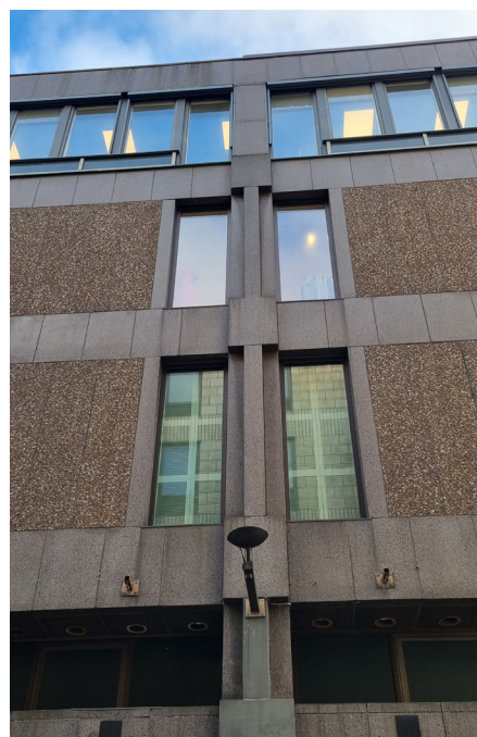
Den bärande stommen är tydligt redovisad i fasaden och klädd med terrazzosten med inslag av labradorsten.
