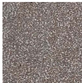
Täta fasadskivor är klädda med fasadskivor med frilagd ballast.
