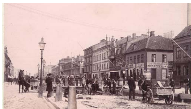
Östra Hamngatan under pågående arbete med att lägga igen hamnkanalen i början av 1900-talet. Källa: GSM.
