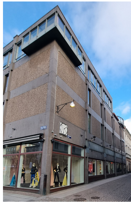
Fasad mot Kyrkogatan med balkong i hörnet.
