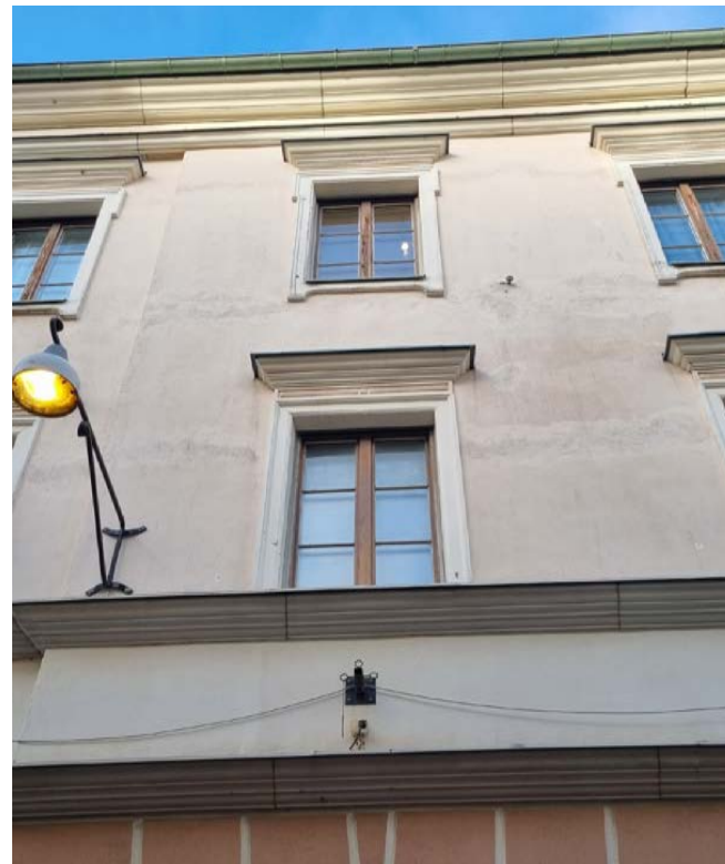
De profilerade gesimserna är utförda i sektioner med tydliga skarvar.
