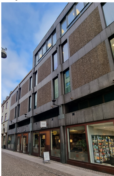
Fasad mot Drottninggatan.
